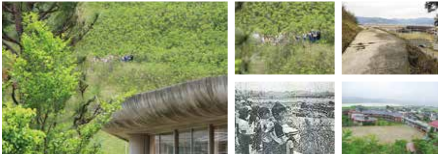
校庭脇の山 崩れないように土留めをし、コンクリートのテラスのようにになっている（5~6m幅で70m以上）。低学年の授業でも使っていた。校長先生はここから何度も写真を撮影している。
